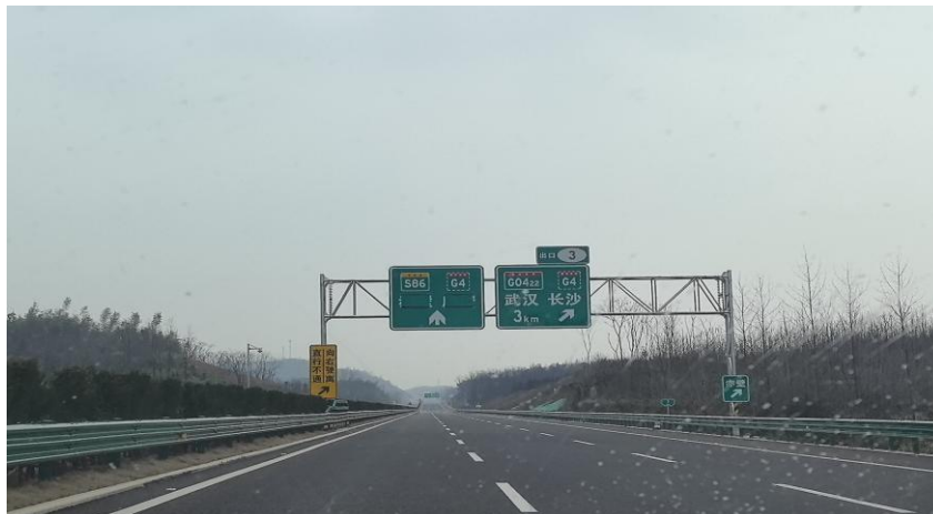
图 3.1-17 赤壁长江公路大桥东延段交通现状
