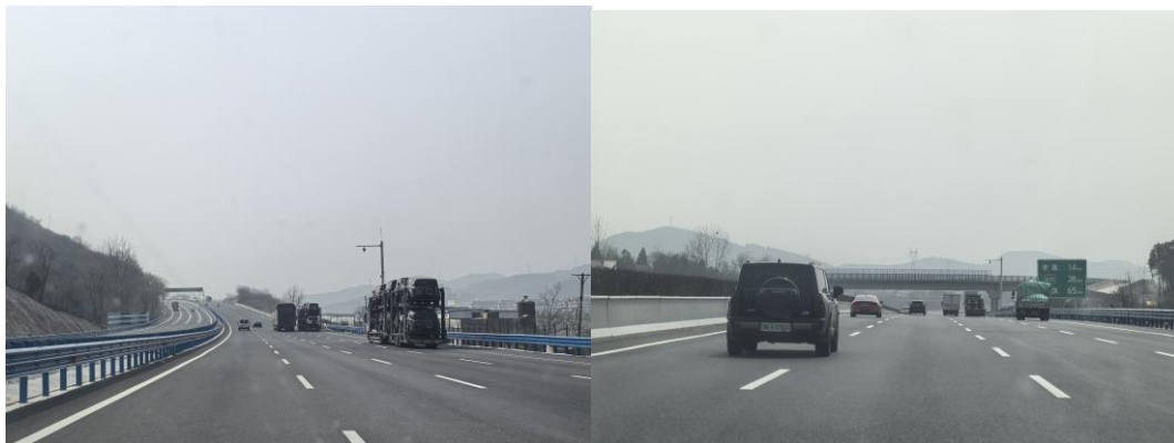
图 3.1-9 京港澳高速湖北北段（南向）交通现状
