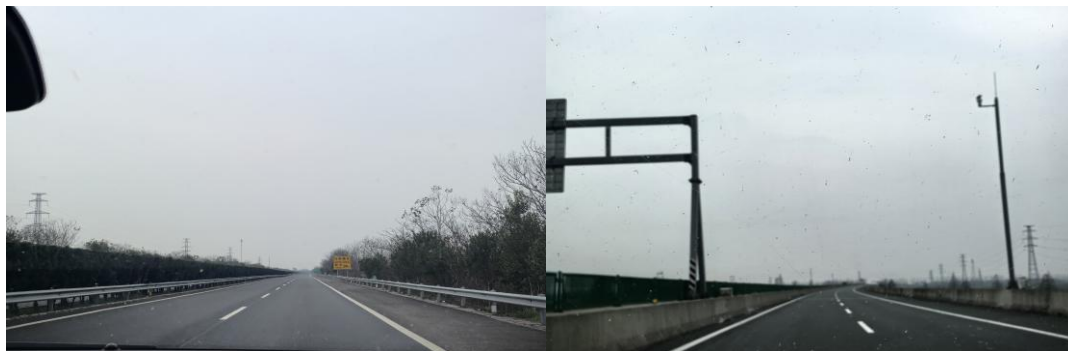
图 3.1-15 汉洪高速（乌金至洪湖段）交通现状
